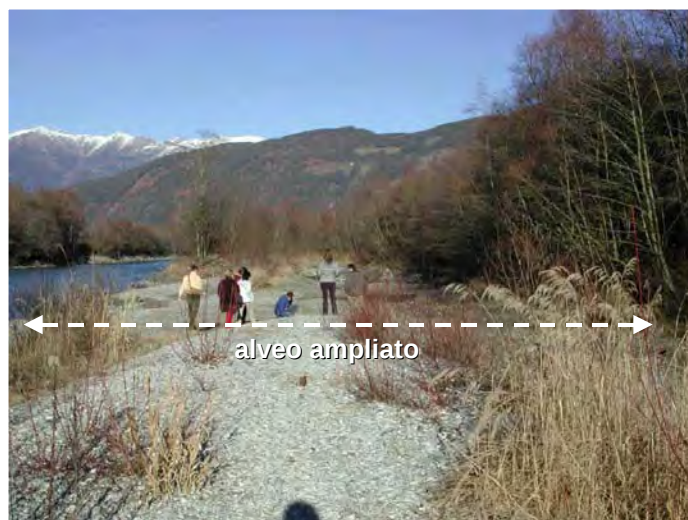
Figura 5.17 – Fiume Drava (Austria). Ampliamento dell'alveo mediante ricalibratura del canale.
