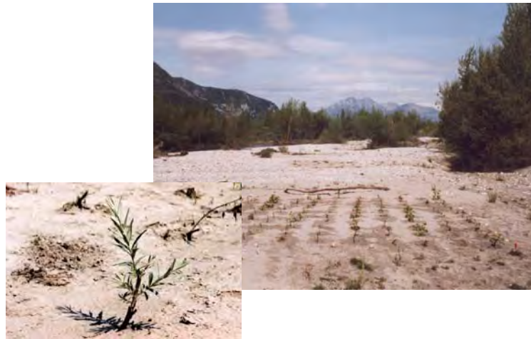
Figura 6.36 – Piantumazione di propagali di salice in alveo.
