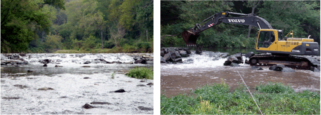
Figura 5.20 - Uno dei tanti esempi di rimozione di briglie per il recupero ambientale (Octoraro Creek dam, USA).
