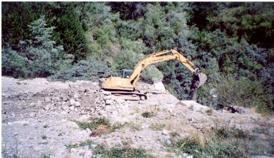
Figura 5.2 - Spostamento di sedimenti a valle di una briglia (Beoux river, Francia).
