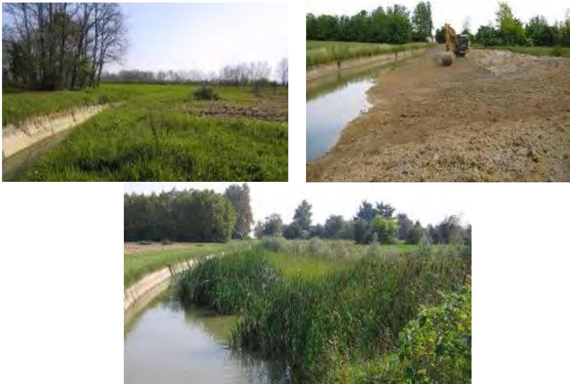
Figura 6.29 – Riqualificazione di un canale rivestito in calcestruzzo - Fonte: Consorzio di bonifica Dese Sile (Mestre – VE).
