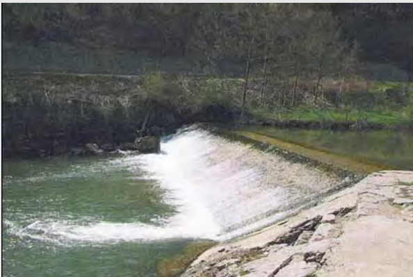
Prima dell'intervento, anno 2002
