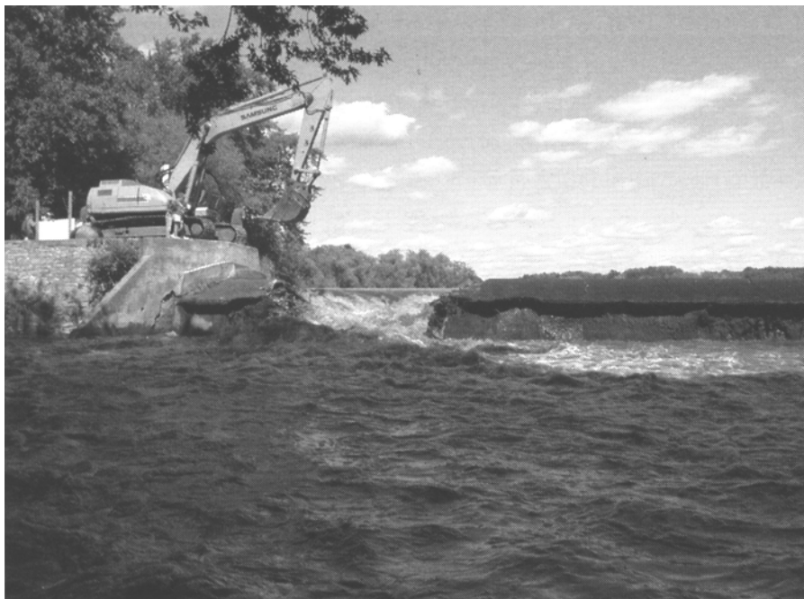
Figura 5.21 - Rimozione di una diga (Koshkonong River, Wisconsin) (da Downs & Gregory, 2004).
