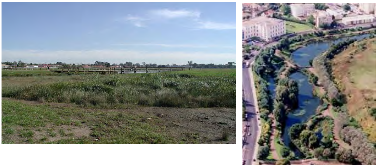
Figura 6.26 – A sinistra: impianto per il trattamento delle acque di prima pioggia in Toscana. A destra: impianto a flusso sommerso per il trattamento di scolmatori di reti miste (Germania)
