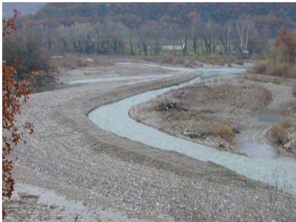
Figura 5.6 – Esempio di intervento di aumento locale della capacità di trasporto sul F.Drome (Francia).
