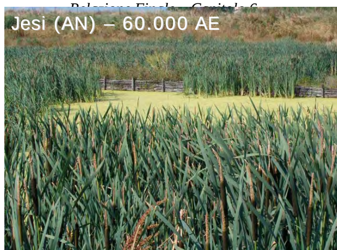
Figura 6.23 – Impianto di post-trattamento di Jesi (Fonte: Irida srl)
